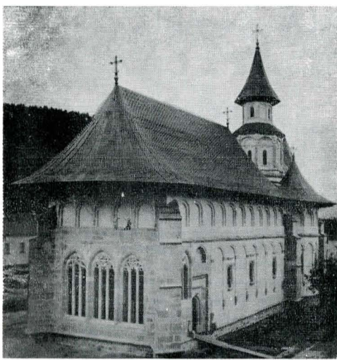
Fig. 1 — Biserica mănăstirii Putna, cu învelitorile refăcute din tablă de covană și cu paramentul din piatră brută tencuit.
